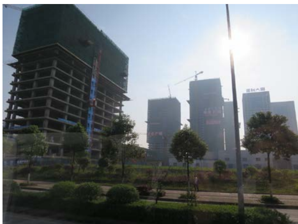
貴陽市郊外のビル建設ラッシュの様子
